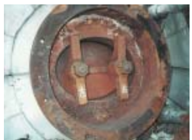
ボイラースチームドラム内楕円面補修 (適用範囲： ~584mm)
