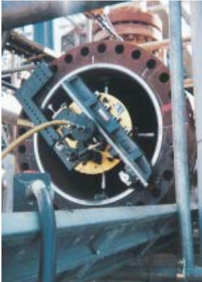
熱交換器シェルフランジ補修 (適用範囲： ~2800mm)
