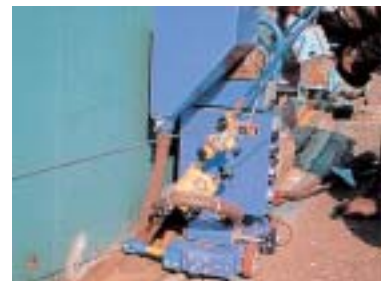
ワイヤーの取付け 既設のバルブフランジ、配管、マンホール等を利用して、高さ400mm程度にワイヤーを取付ける。取付部がない場合、アングルを利用してワイヤーをセットする。
