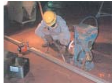
自動溶接機のセット
