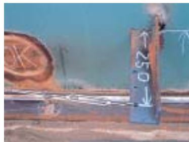
ワイヤーの取付け 既設のバルブフランジ、配管、マンホール等を利用して、高さ400mm程度にワイヤーを取付ける。取付部がない場合、アングルを利用してワイヤーをセットする。
