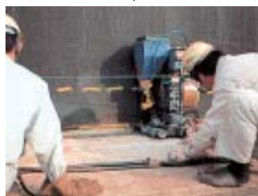
自動溶接機のセット
