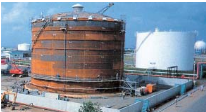
地盤改良工事（ディープパイプロ工法）
