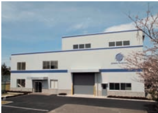
「トレーニングセンター」教育・訓練センター棟
